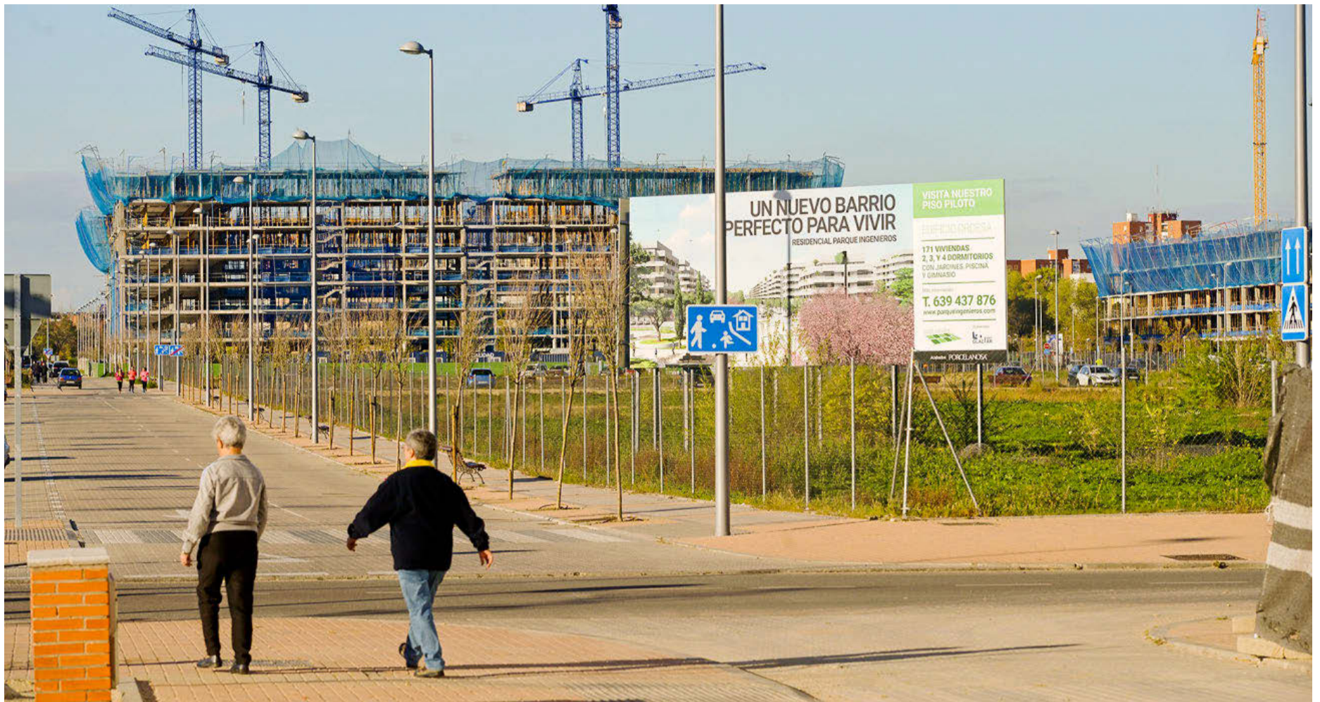
Bloques de pisos en construcción en Parque Central de Ingenieros, el nuevo ámbito que crece en el distrito de Villaverde, al sur de Madrid capital, que albergará casi 2.000 viviendas. JOSÉ S. GUTIÉRREZ
